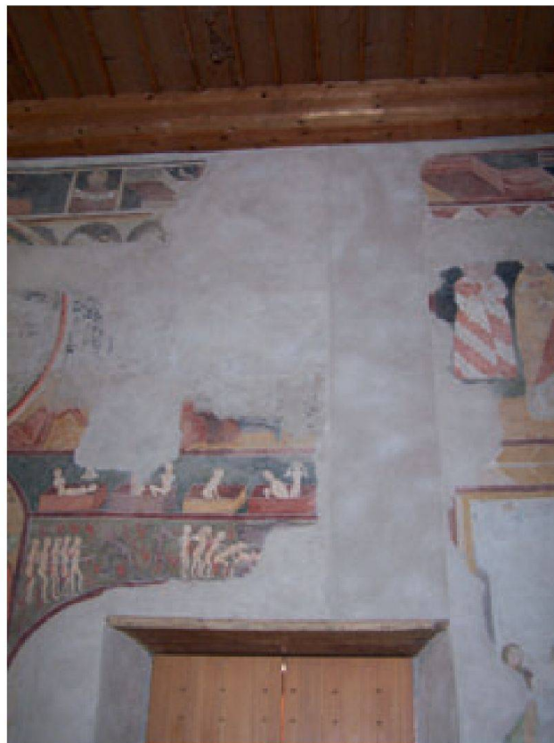
Fig. 1 Chironico, S. Ambrogio, controfacciata. È ben visibile la fascia verticale lungo la quale si appoggiava il muro di separazione delle due navate. A sinistra in basso è leggibile l'arco dell'antico ingresso, sopra il quale sono dipinti l'Inferno e la Resurrezione dei corpi .
