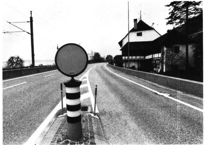
Abb. 4b Twann, Wingreis, Rebhaus der Familie Thormann. Zustand nach dem Bau der Nationalstrasse N5, 1983.
