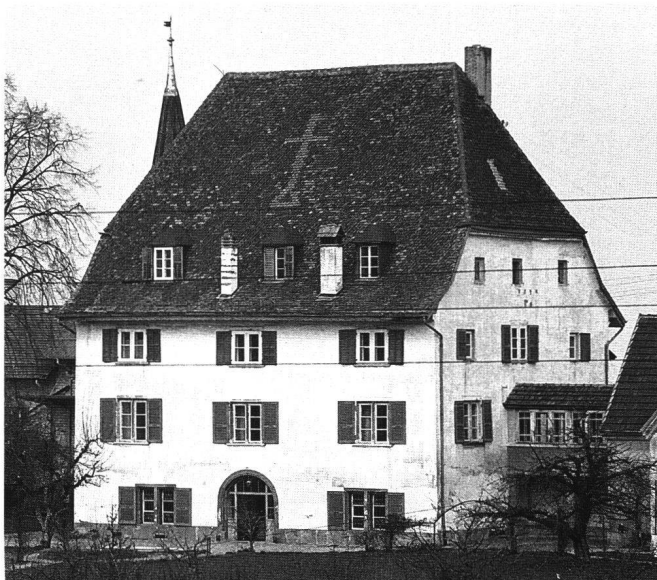
Abb.9 Überstorf, «Schloss» Englisberg. Spätgotischer, 1505 datierter Kubus mit zwei Obergeschossen und steilem Walmdach. Aufnahme 1976.
