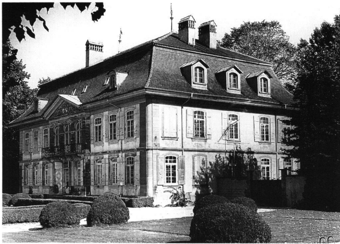
Abb. 13 Middel, Herrenhaus de Griset de Forel, gebaut 1748/49 nach Plänen des Architekten Johann Paul Nader. Blick von Südwesten auf das Hauptgebäude. Aufnahme 1984.
