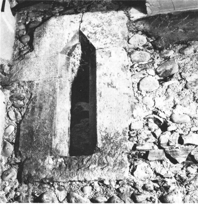
Abb. 7: «Zum Luchs» (In Gassen 3): Frühgotischer Lichtschlitz im Erdgeschoss des Kernbaus.
