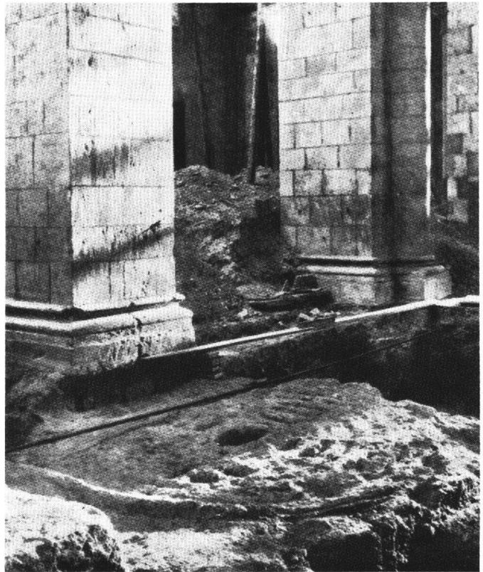
Abb. 13 Mönchengladbach. Ansicht der Mörtelscheibe von Südwesten. Besonders auffällig sind hier die konzentrischen Wellen.
