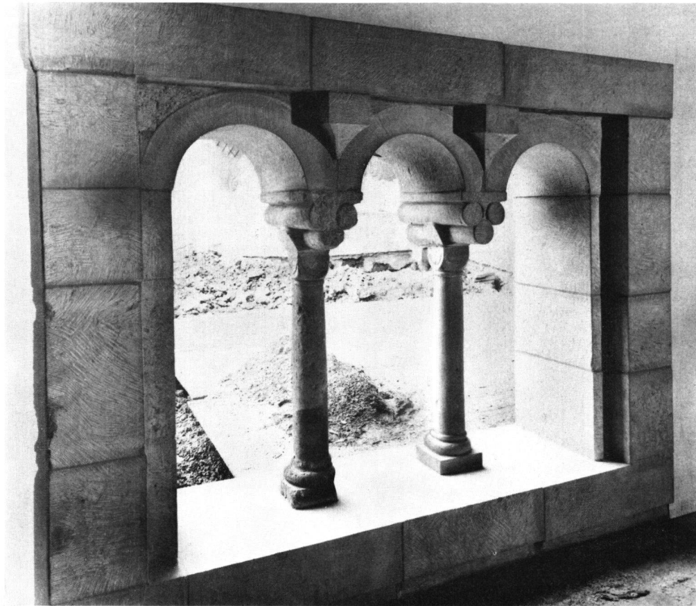
Abb.111 Rekonstruktion eines romanischen Arkadenteils. In der Westwand des 1974 neu errichteten Archivbaus
