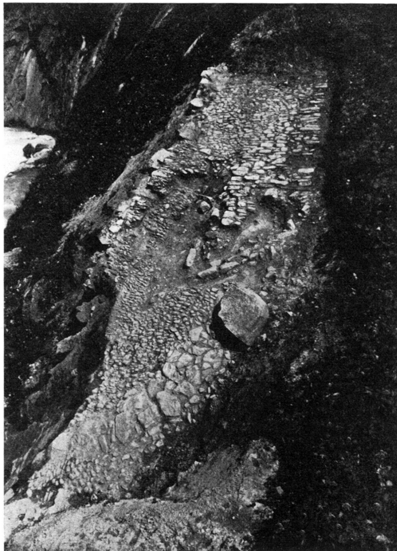
Abb. 2. Zufahrtsweg zur alten Teufelsbrücke von Andermatt her.
