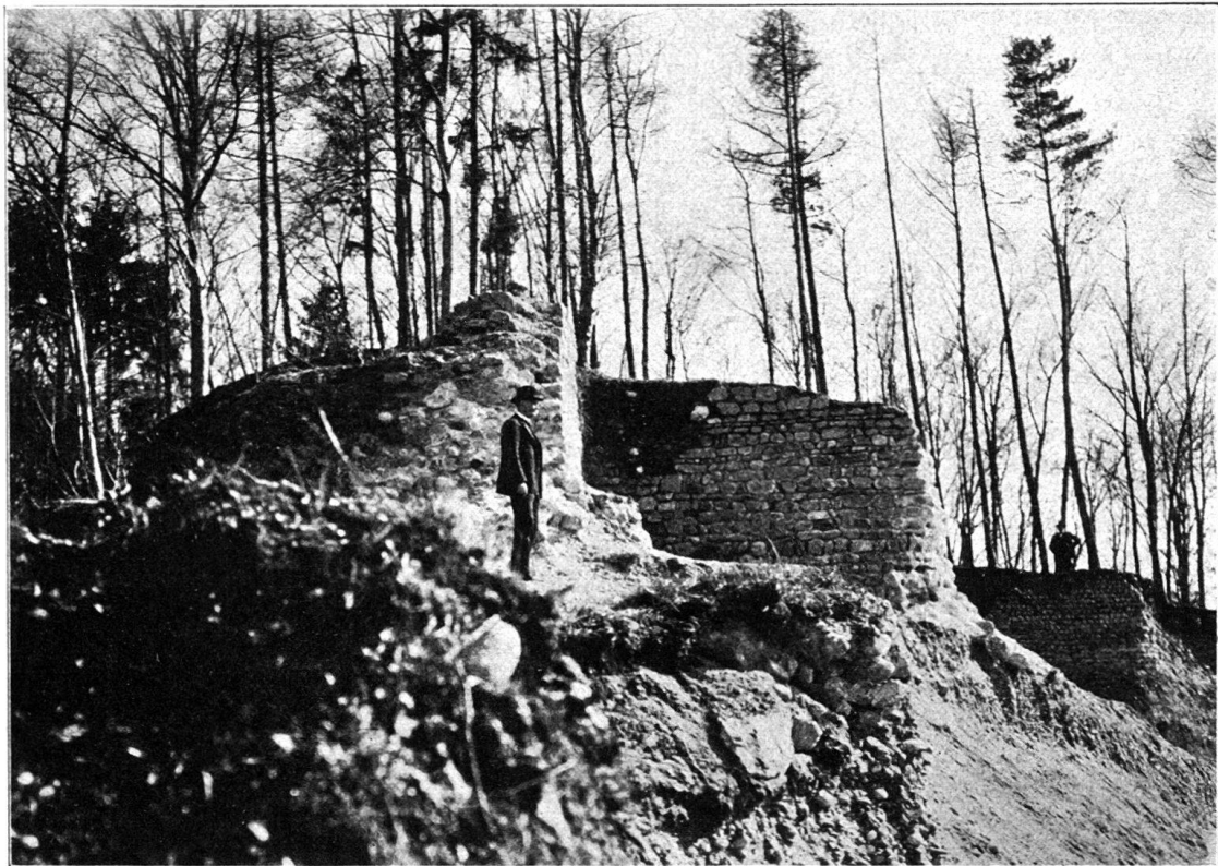
Abb. 3. Ansicht der Ruine von Norden.
