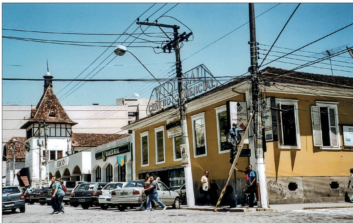
Willisau-Center angrenzend an die Heilpädagogische Schule. Die Stadt ist vernetzt: Kilometer lange Strom- und Telefonkabel prägen das Stadtbild. Foto Jean-Luc Brühlhart
