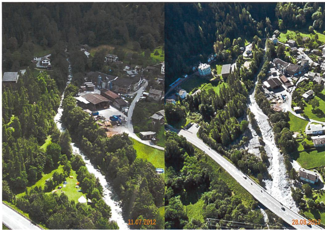
Bild 3. Das Gerinne der Bondasca im Bereich Bondo vor (links) und nach den Murgangereignissen von Sommer 2012 (rechts).
