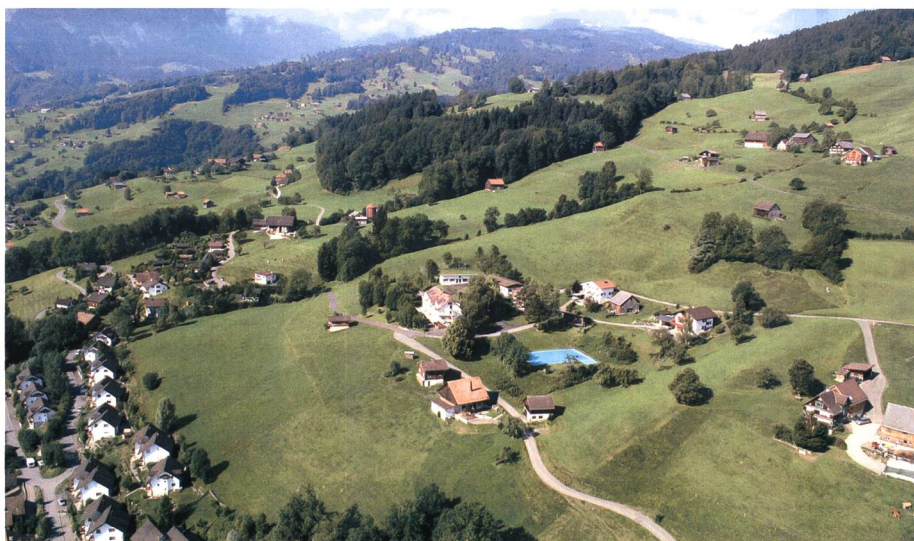
Das ehemalige Asylzentrum Eichlütte (Bildmitte) in Gams. Das Gebäude ist im August 2006 einem Brand zum Opfer gefallen. Archiv Politische Gemeinde Gams
