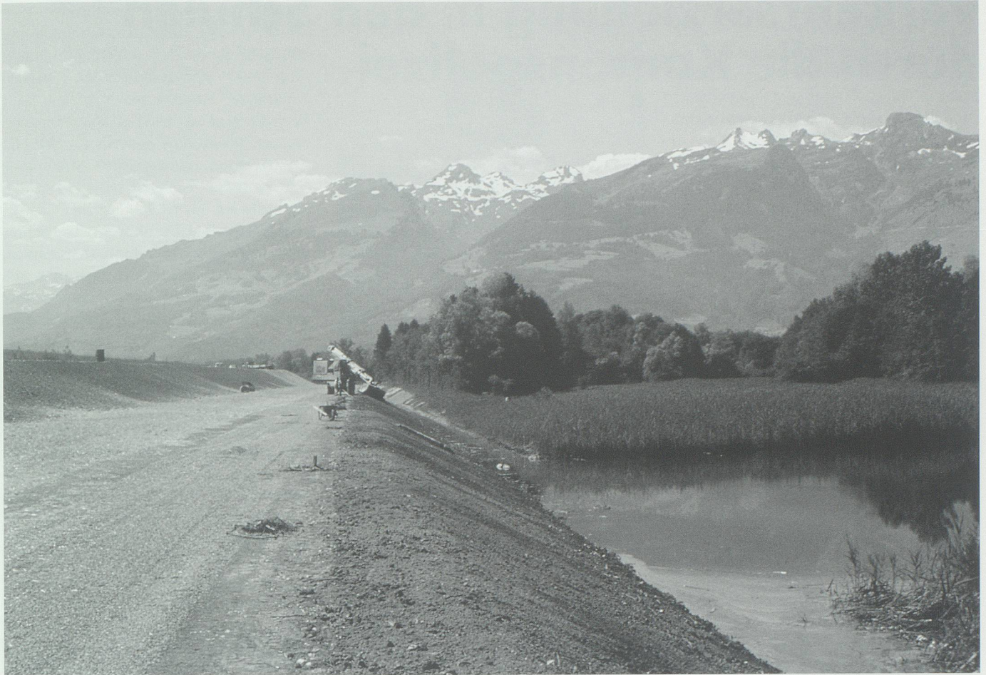
Der frühere Mündungslauf des Grabserbaches (Wiesenfurt) wurde bei Haag vom Strassentrassée (links, erhöht) und von den angrenzenden Planierungen angeschnitten. Das Gebiet rechts liegt seit der Rheinsohlenabsenkung infolge Kiesentnahme für die N 13 trocken.
