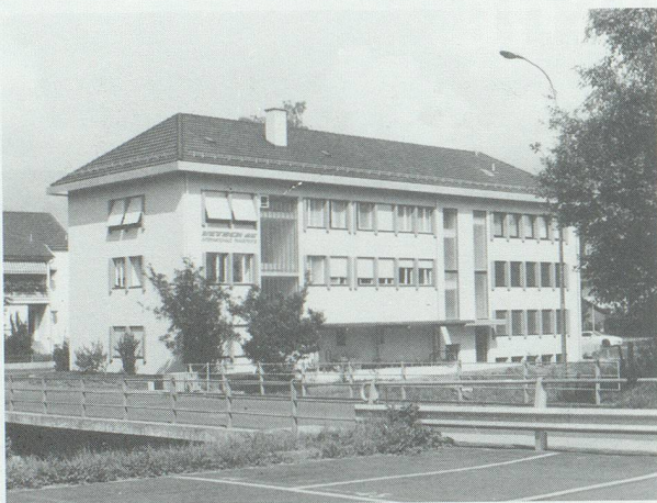
Verwaltungsgebäude der im Jahr 1901 gegründeten inter- nationalen Spedition an der Technikumstrasse, Buchs
