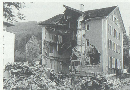
11. Oktober: In Buchs wird die «alte Bank» abgebrochen.
