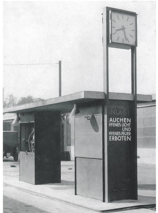
DAM, Frankfurt: Grossgarage der Frankfurter Automobilroschken-gesellschaft, Tankstelle
