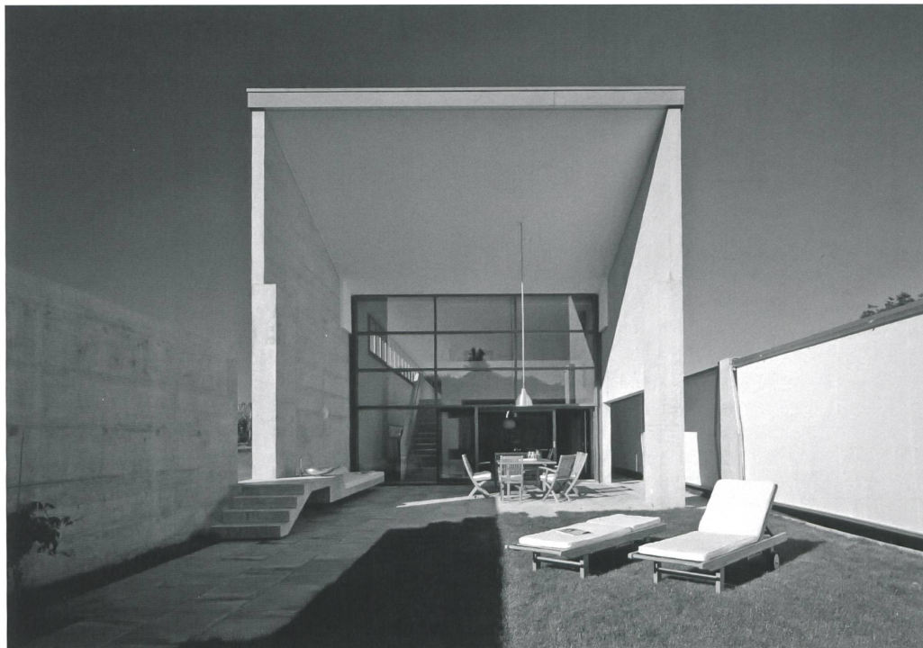
Bleibt ohne urheberrechtlichen Schutz: Die Maison Belfiore in Givrins VD, 2000. Bild: Vincent Mangeat
