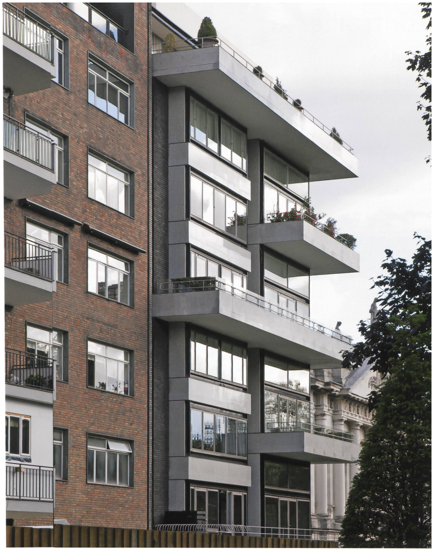
Ganz im Stil seiner Zeit ist die Erdgeschosszone des Appartementhauses leicht und filigran ausgebildet.
