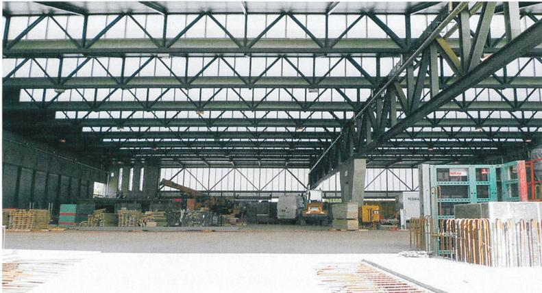
Sheds, Fachwerkträger und nur eine Stütze: Rangierfläche für das Gerät der Swisscom. Die Struktur blieb erhalten, in das Luftvolumen sind jetzt Turnhallen eingebaut.
