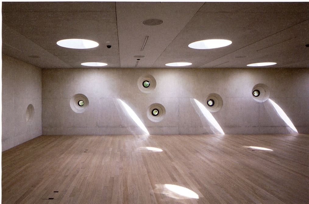
Betonlamellen überspannen Kantine und Eingangshalle (Bild oben). Die Therapie Räume im Obergeschoss (unten) liegen hinter der Betonfassade mit den fußballgrossen Öffnungen.
