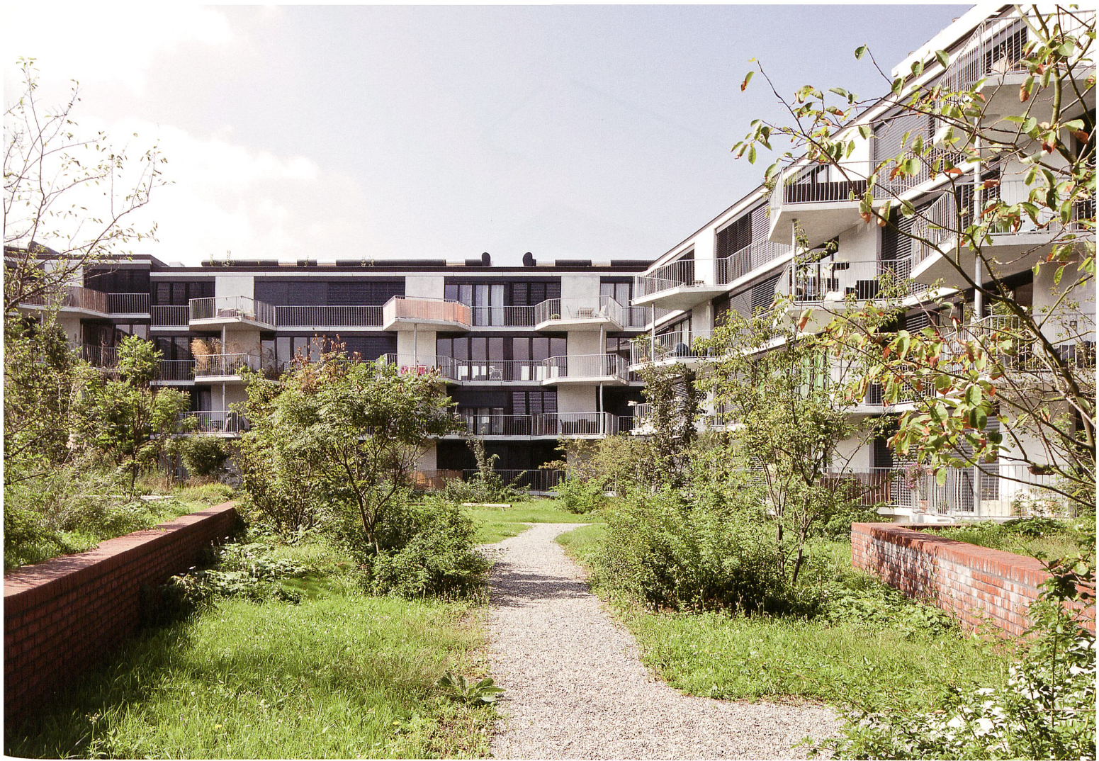
Garten auf dem Dach
