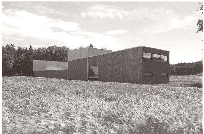
Die dreiteilige Sternwarte: Beobachtungsplattform mit Schiebedach, offener Hof und beheizter Gebäudeteil mit Planetarium, Foyer und Schulungsraum (von links nach rechts).
