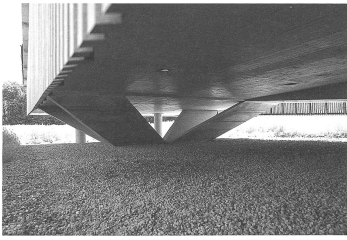
Zwei V-Säulen tragen die Beobachtungsplattform
