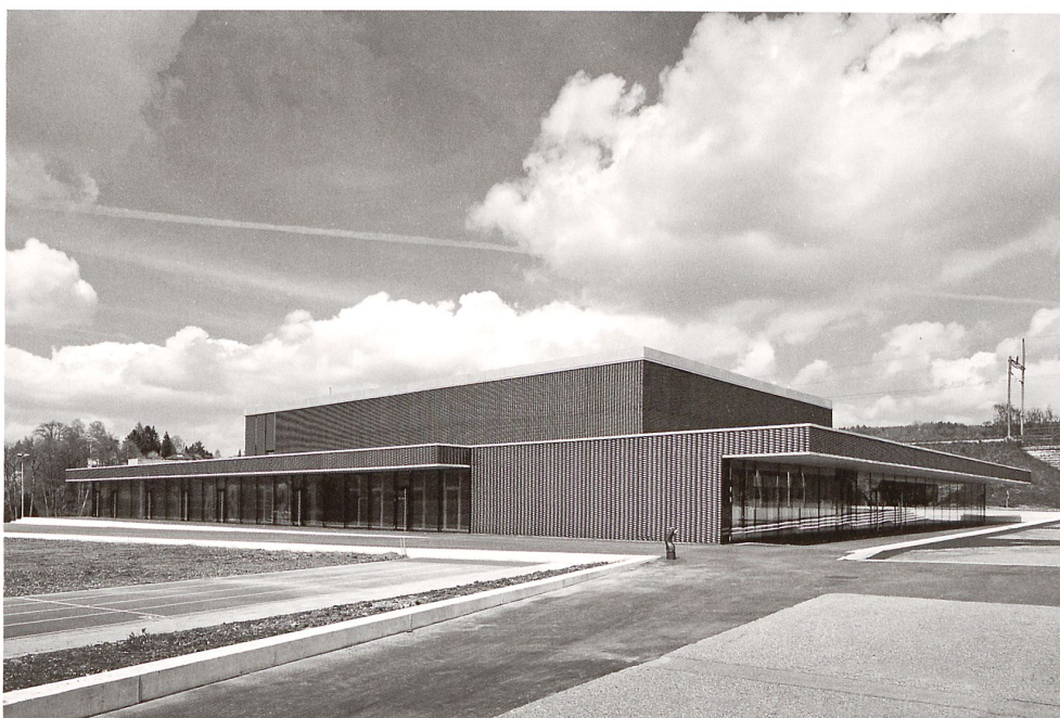
Hauptansicht: rechts der Eingang mit Foyer, im Hintergrund der Bahndamm
