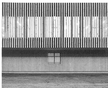
Detail der Südwestfassade
