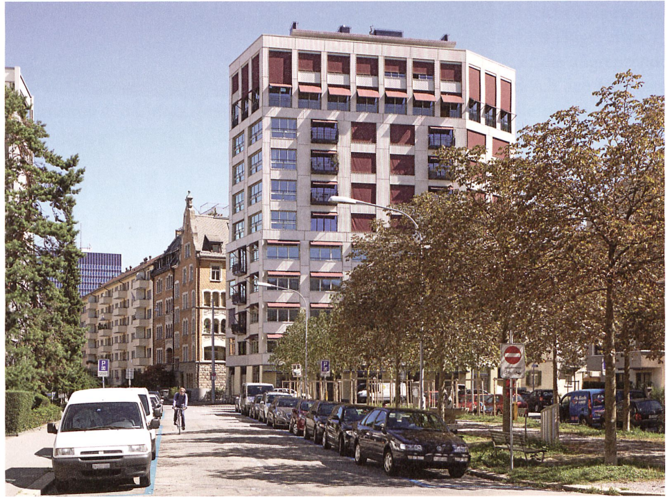
Das Wohnhochhaus reiht sich in die Gründerzeitstadt ein und bezieht sich auf eine vor bald hundert Jahren angelegte kleine Parkanlage an der Weststrasse. Bild: Andrea Helbling
