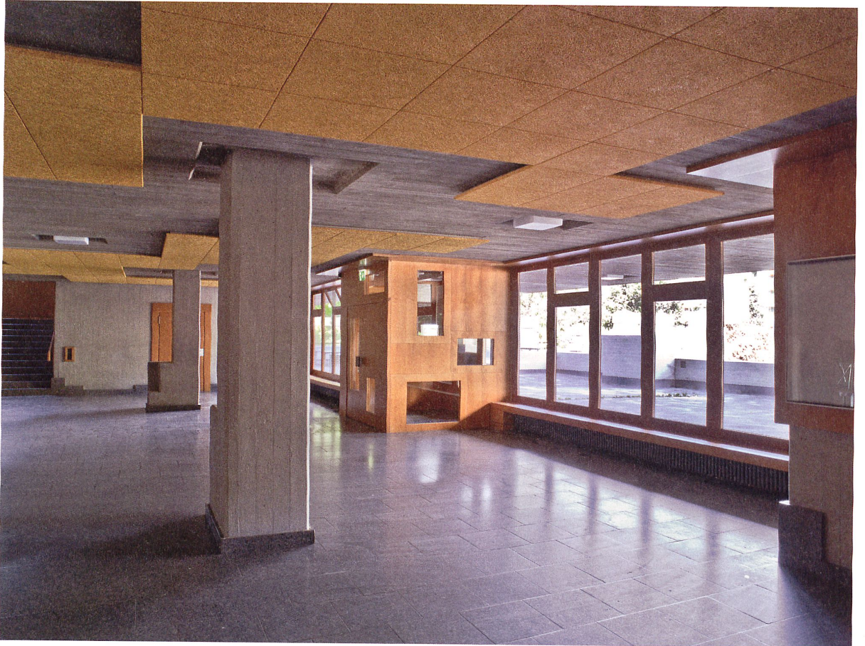
In der Eingangshalle wurden die Windfänge neu gestaltet und eine Akustikdecke eingebracht. Beide Elemente weben als formale Paraphrase die ursprüngliche Architektur weiter.
