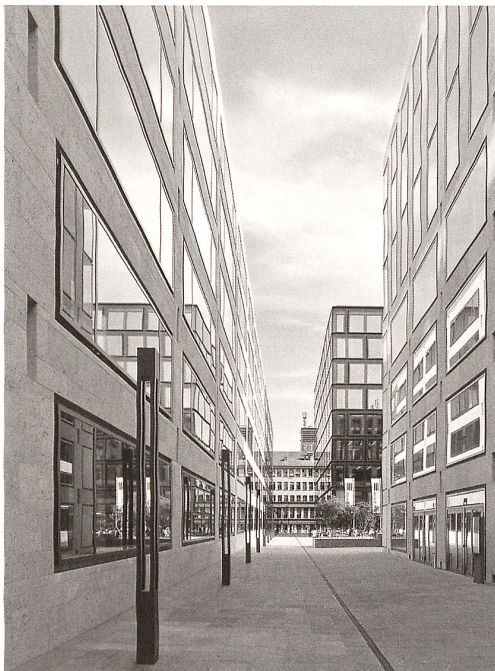
Schmale Gasse auf der Platzebene mit Blick auf das Hauptgebäude der Pädagogischen Hochschule, ganz hinten die Sihlpost.
