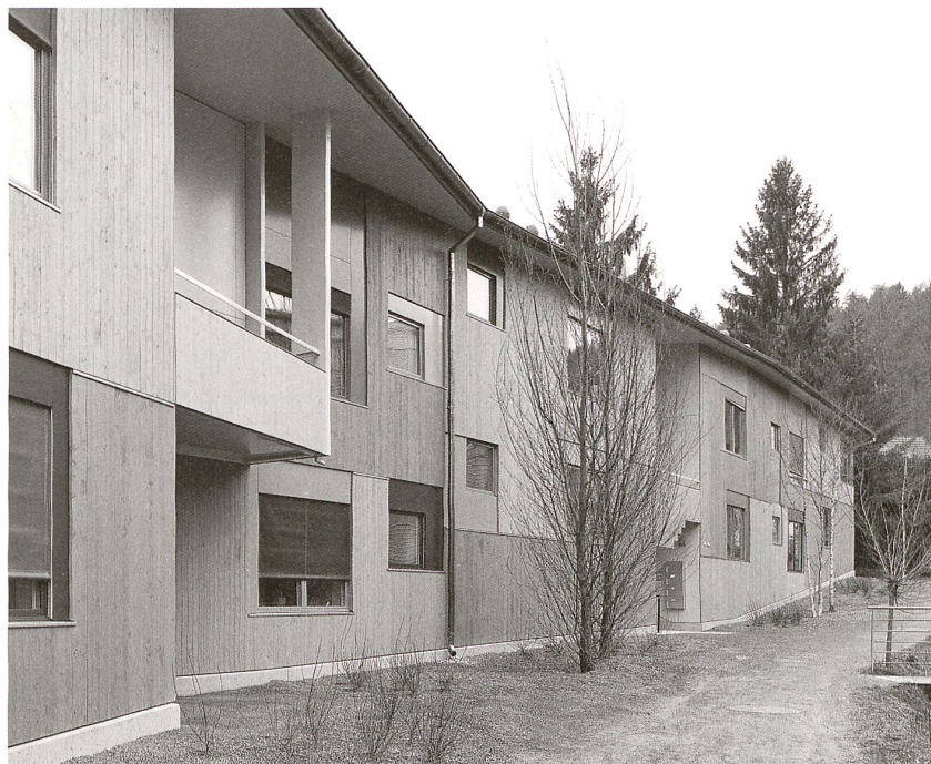
Ansicht der Nordostfassade am freigelegtem Bach
