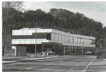
Ansicht von der Schosstabsstrasse
