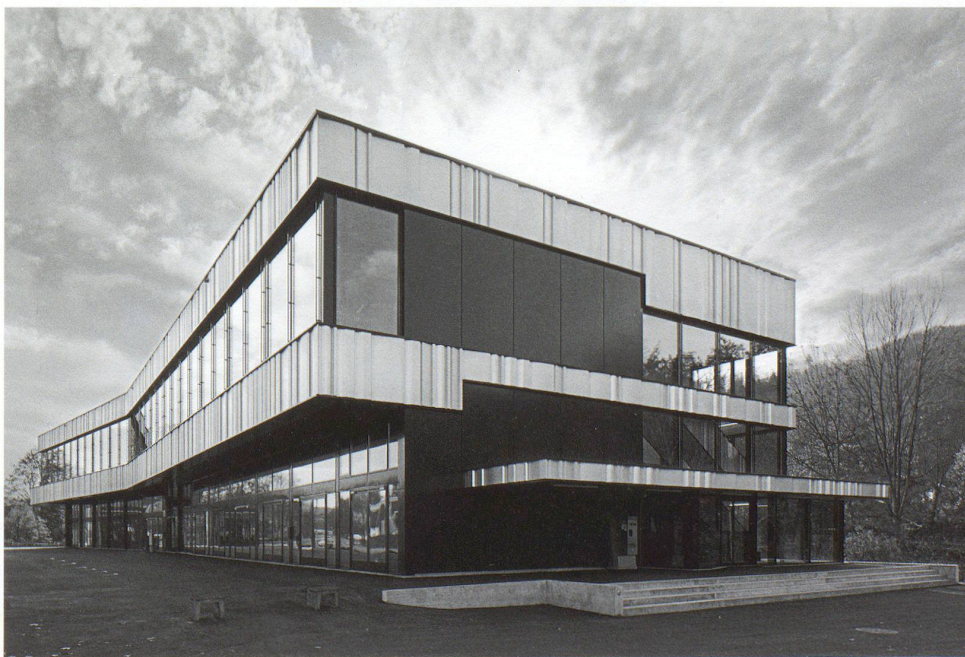
Westliche Stirnfassade mit Eingangsbereich
