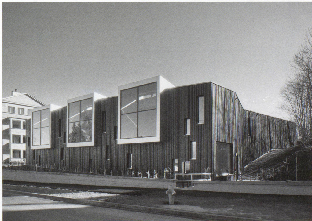
Ansicht von der Brechbühlerstrasse
