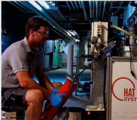
*Nach dem Mischen und Dosieren wird das Beschichtungsmaterial in Kartuschen für die eigentliche Innenbeschichtung vor Ort abgefüllt.*
