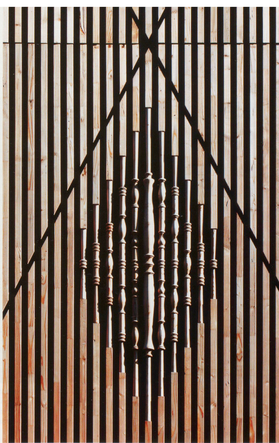
Porosität: Fassadendetail mit handgedrechselten Stäben
