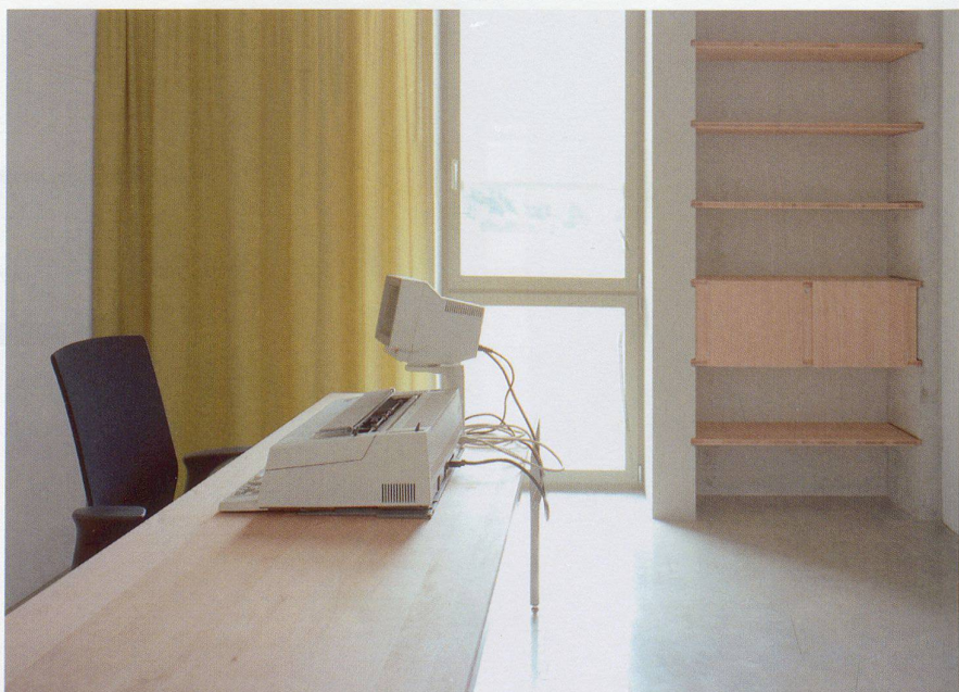
Büroarbeitsplatz mit direkt in die Tragstruktur eingelassenen Tablaran
