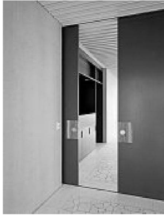
Mobile Trennwand im Saal
