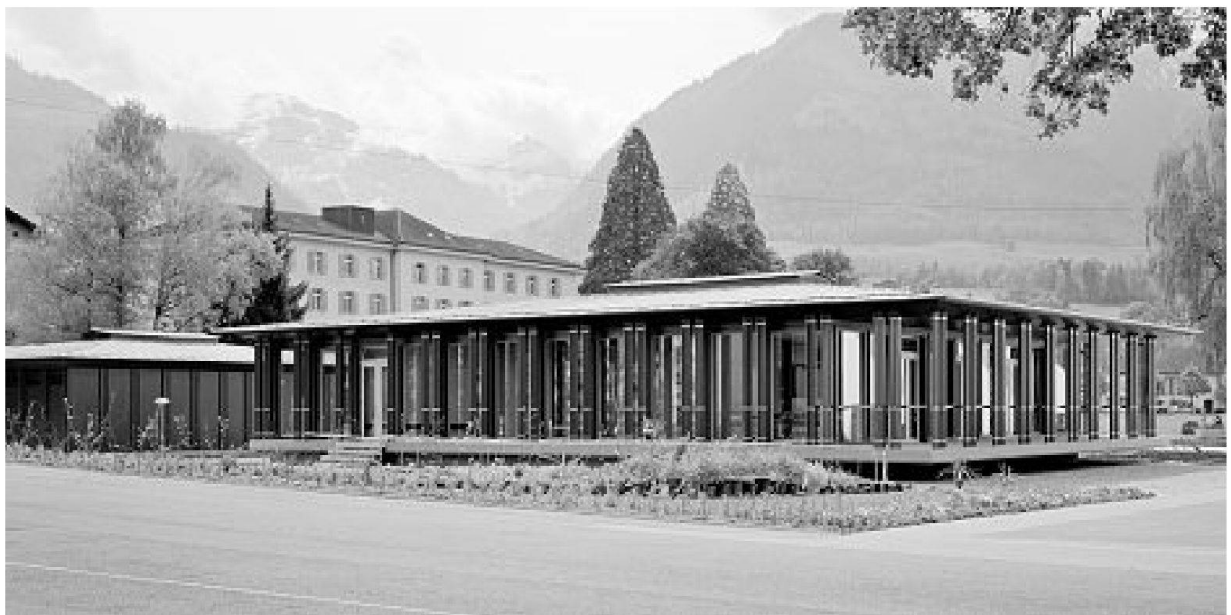
Anlage der Gärtnerei mit Nebengebäude (links) und dem vom Erdboden abgehobenen Hauptgebäude
