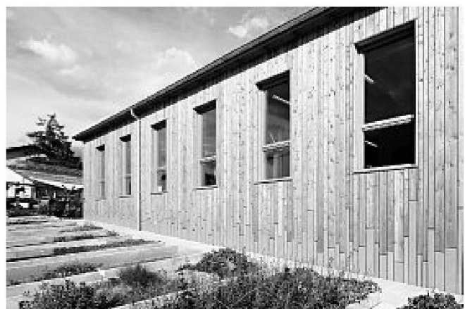
Faserzementplatten ersetzen den Sockel
