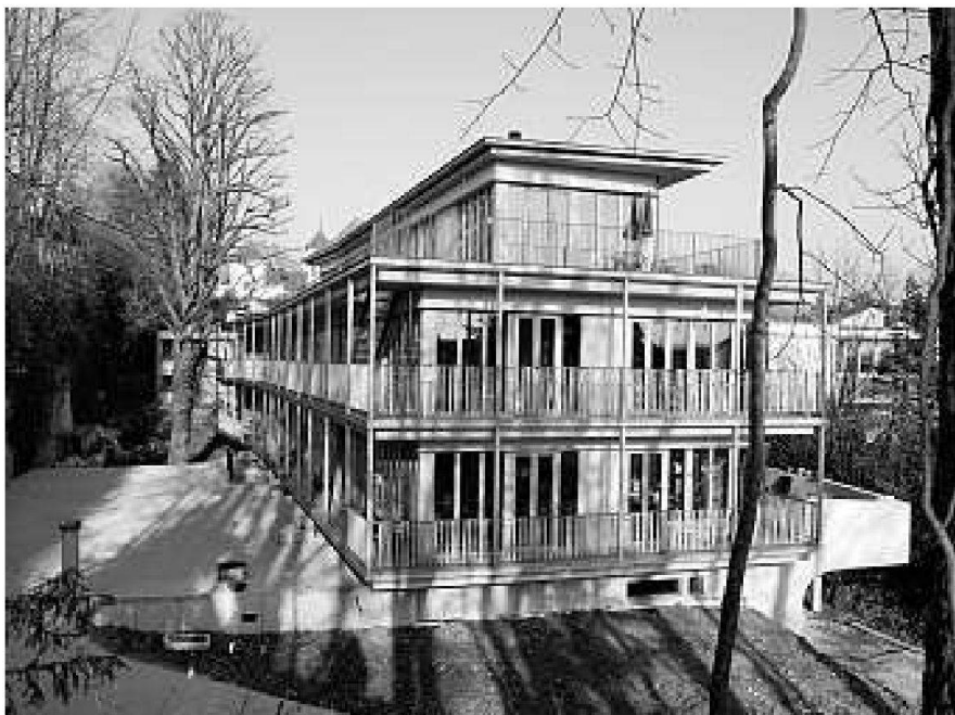
Holzständerbauweise auf betoniertem Sockel
