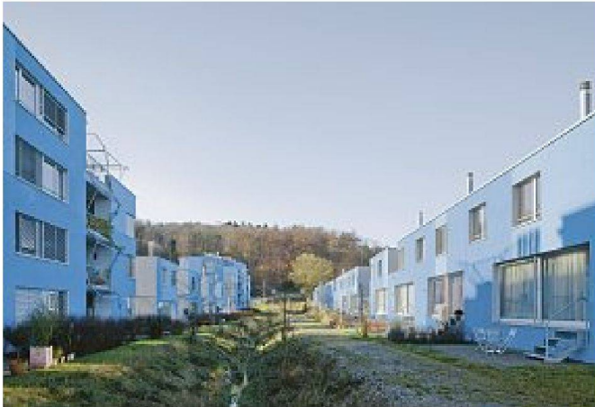
Back-to-Back-Situation: In den Grünräumen hinter den Häusern sind jeweils die Sitzplätze und ein Weidenbeet privat, die dazwischenliegende Wiese öffentlich – zwischen Lang- und Mehrfamilienhäusern (oben) ebenso wie zwischen Reihenhäusern und gereihten Einfamilienhäusern bzw. Mehrfamilienhäusern an den Enden der Zeile (unten).
