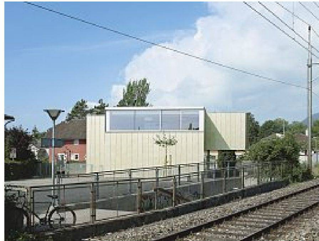
Kindertagesstätte Corcelles NE, Blick von Osten auf die Zugangsseite
