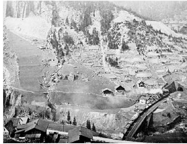
Sicht auf die obere Watteringerbrücke nach 1893. Zur Stabilisierung des Geländes baute die Gotthardbahngesellschaft oberhalb des Bahntrassees unzählige Stützmauern. Die Steinhalde links oben besteht aus Ausbruchmaterial des Naxberg-tunnels, der von der Rohrbachbrücke (rechts oben) Richtung Göschenen führt. Bild: Sammlung Verkehrshaus der Schweiz, Luzern
