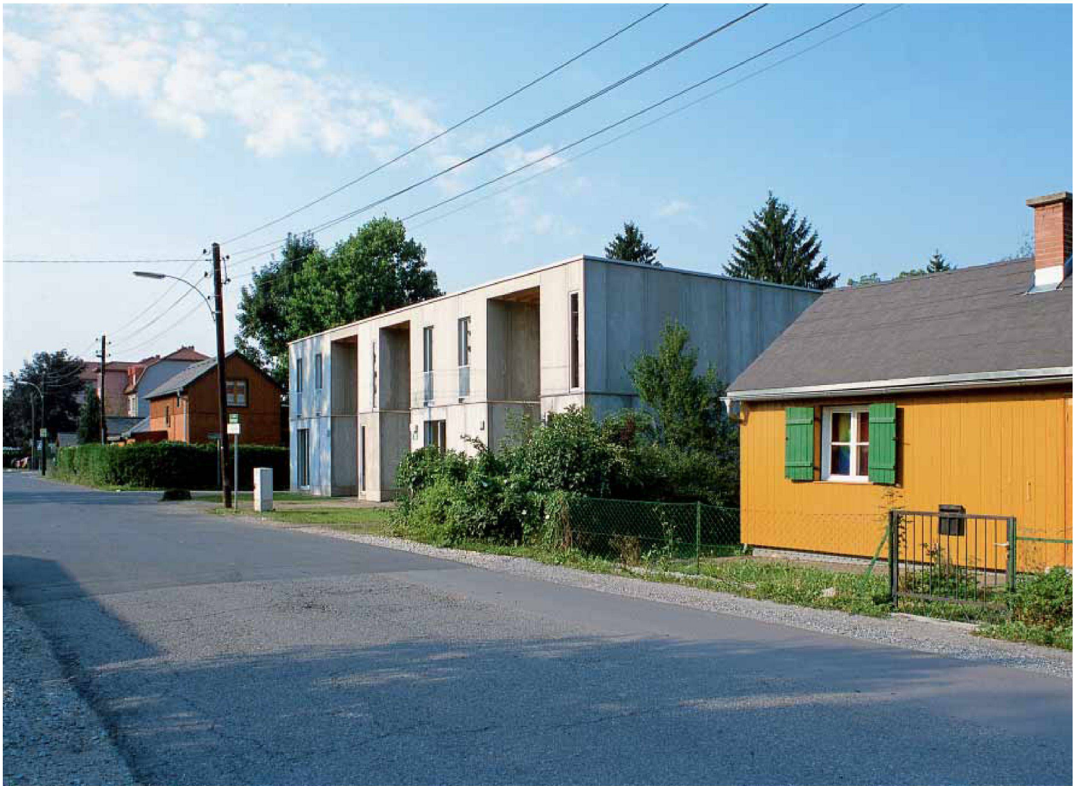
Nachverdichtung der Barackensiedlung Grünanger. Unten: Selbstbauerweiterung eines bestehenden Gebäudes. – Alle Bilder: Architekturhaus Wiener Strasse
