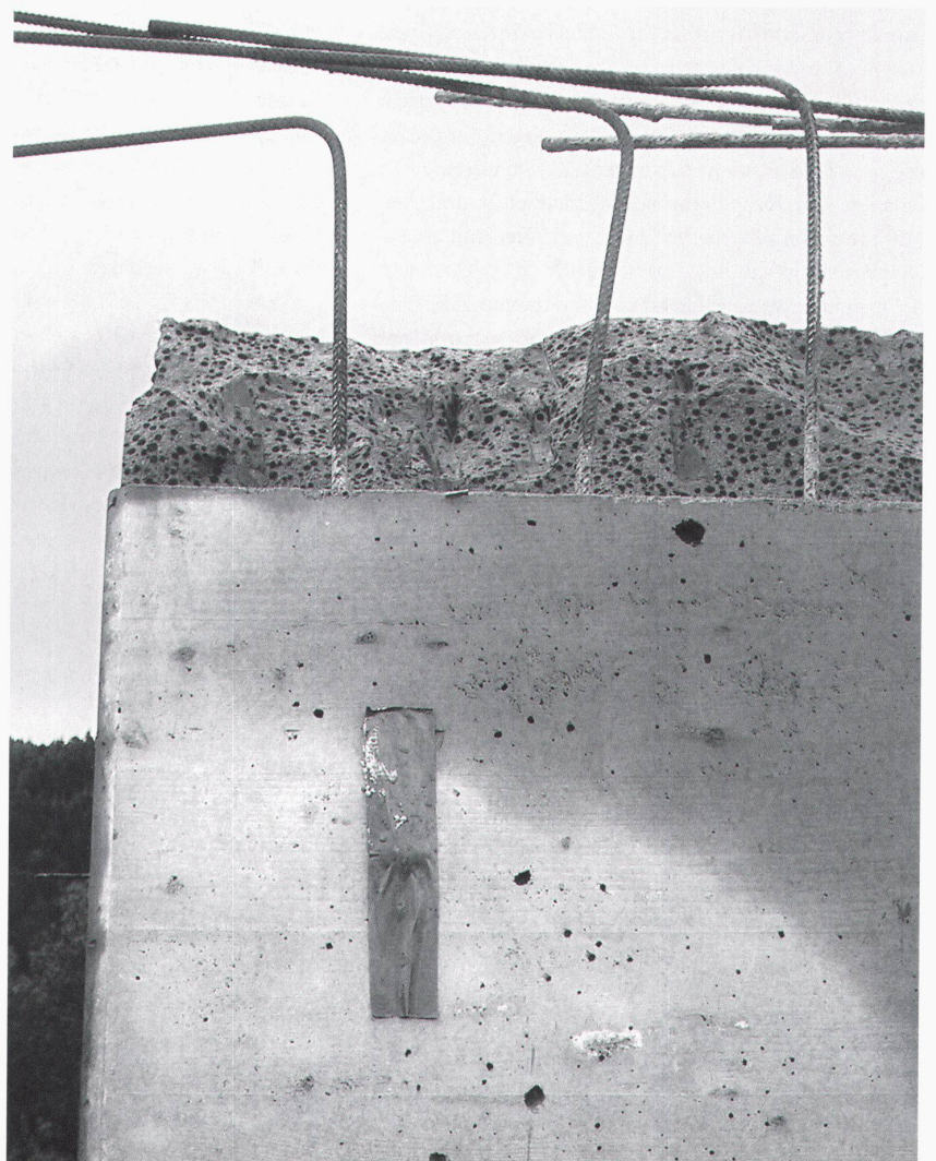
Konstruktionsdämmbeton mit Zuschlägen aus Blähton und Blähglas. – Bild: Felix Jerusalem, ETH Zürich.
