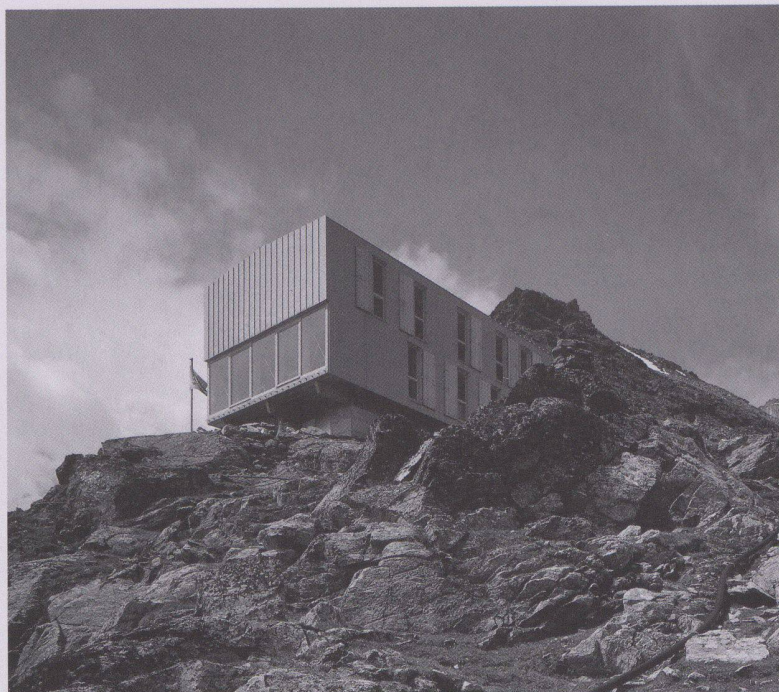
Bilder: Claudio Merlini, Jean-François Kälin (Baustelle)
