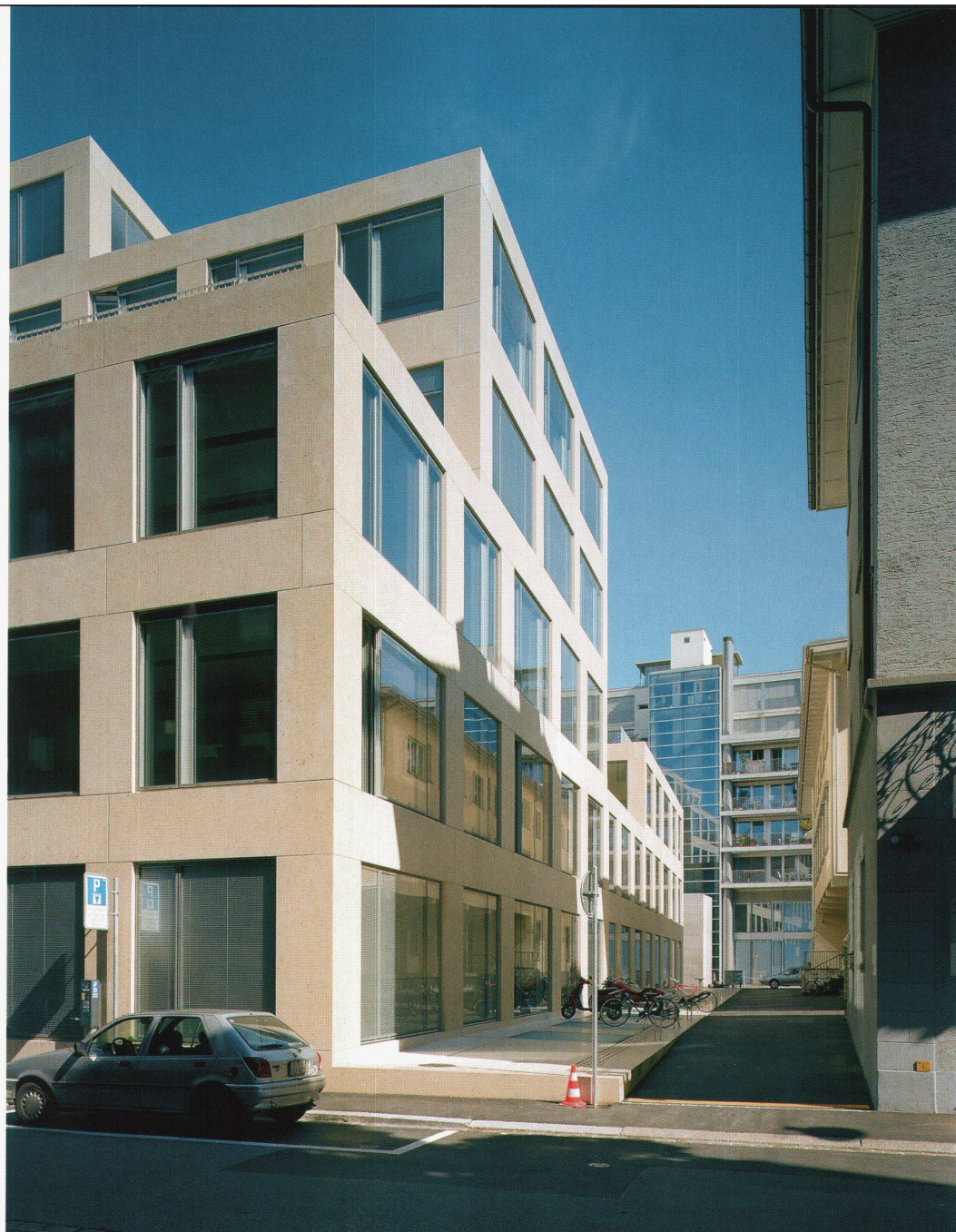
Rückwärtige Fassade mit Blick nach Osten
