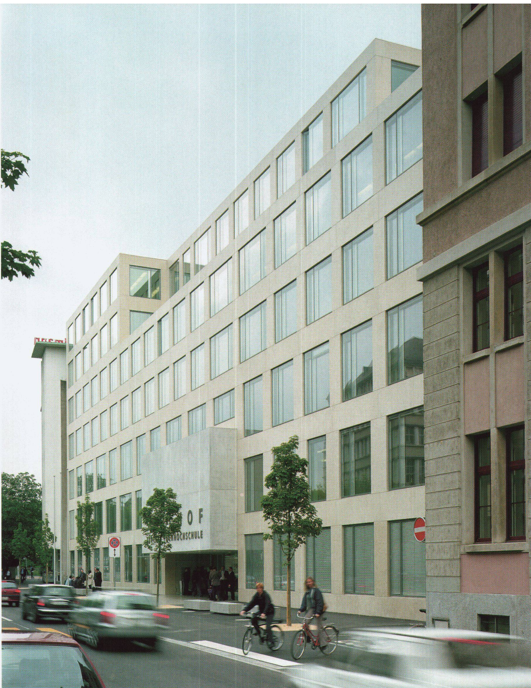
Fassade mit Eingang an der Lagerstrasse
