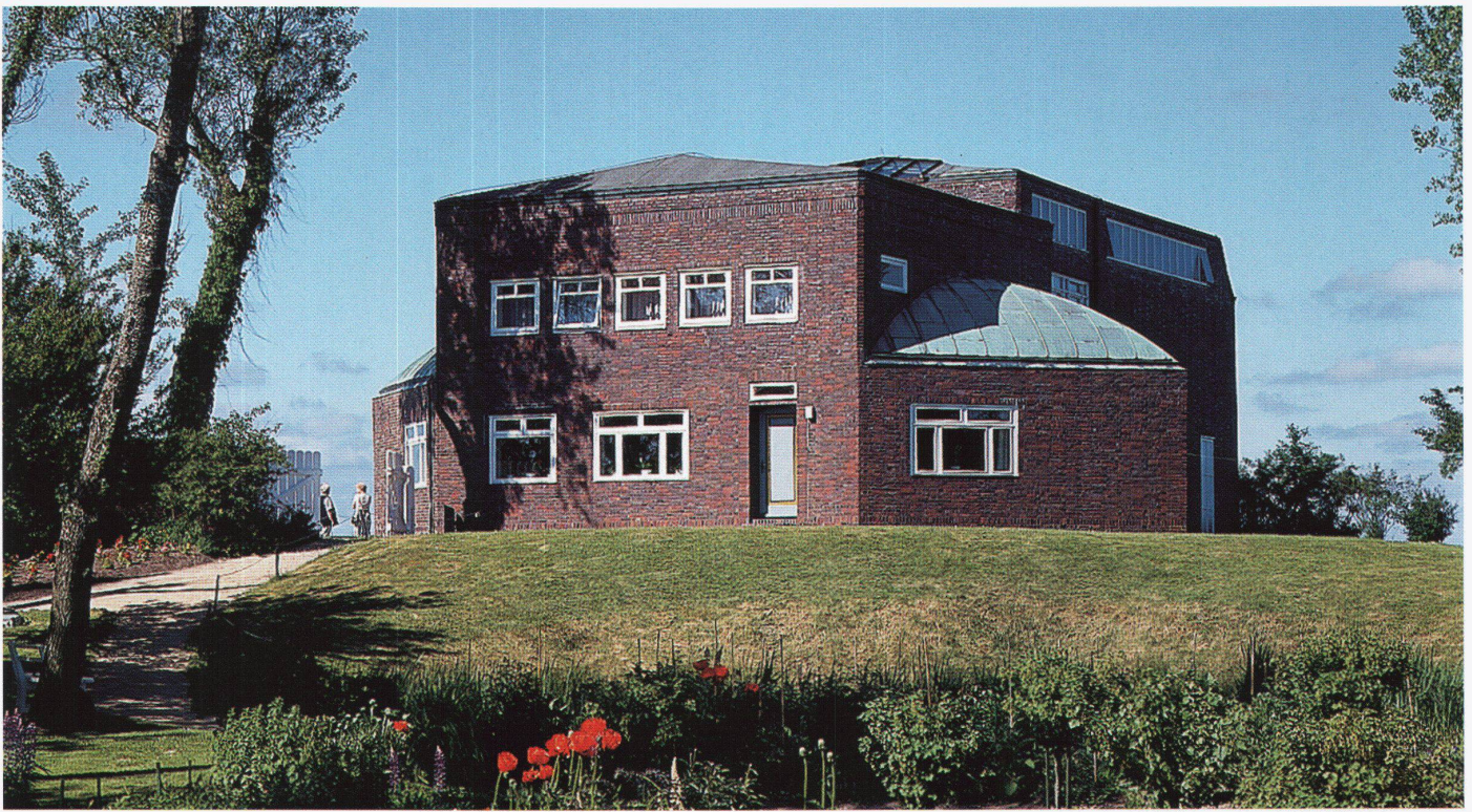
Ansicht von Südosten
