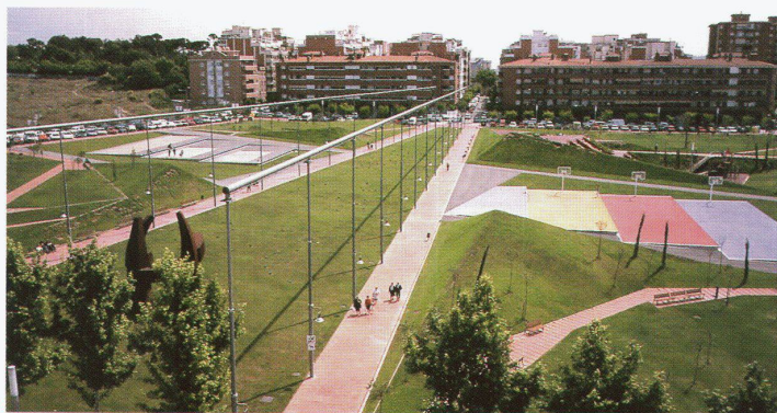
4-5 Parc de la Solidaritat, Esplugues de Llobregat: Überdeckung der Ringstrasse und Brückenschlag zwischen zwei Quartieren. Zwei laterale Fahrstrassen und zwei zentrale Gehwege verbinden die beiden vormals vom Ringstrasseneinschnitt getrennten Stadtteile. Die Wege werden nachts aus 12 Metern Höhe mit Kunstlicht-Strängen beleuchtet: der Parkraum kommt zu überraschender Monumentalität, selbst aus der Perspektive der Ringstrasse (Architekten Sergi Gòdias und Xavier Casas, Projekt 1995, Ausführung 1998) Bilder: L. Jansana
