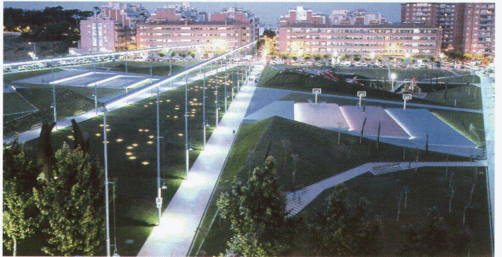
4-5 Parc de la Solidaritat, Esplugues de Llobregat: Überdeckung der Ringstrasse und Brückenschlag zwischen zwei Quartieren. Zwei laterale Fahrstrassen und zwei zentrale Gehwege verbinden die beiden vormals vom Ringstrasseneinschnitt getrennten Stadtteile. Die Wege werden nachts aus 12 Metern Höhe mit Kunstlicht-Strängen beleuchtet: der Parkraum kommt zu überraschender Monumentalität, selbst aus der Perspektive der Ringstrasse (Architekten Sergi Gòdias und Xavier Casas, Projekt 1995, Ausführung 1998) Bilder: L. Jansana
