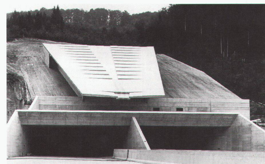
Zürich, ETH-Zentrum: Flora Ruchat-Roncati, Transjurane N 16, in Arbeitsgemeinschaft mit «La Transjurane» und Renato Salvi, 1989/97
