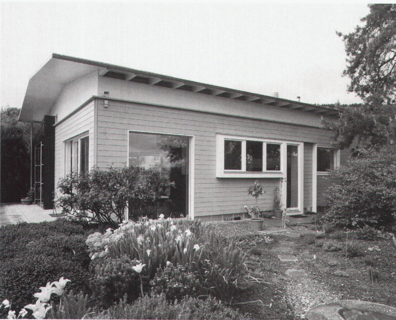
Südfassade Façade sud
