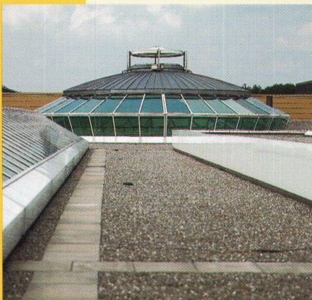
Umbau Einkaufszentrum Glatt. Mit Sarnafil T.
