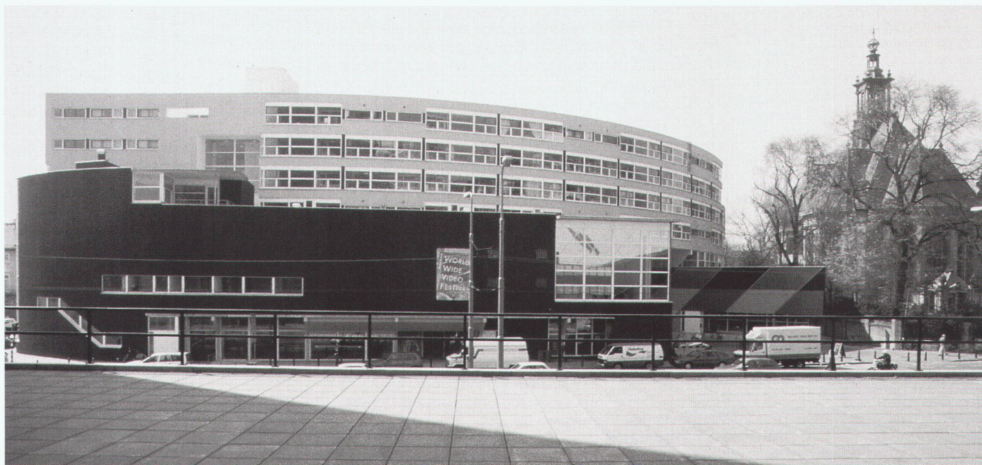
Links Kinotrakt mit Café, rechts Foyereingang, darüber drei Wohn- geschosse
