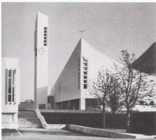
Kirche in Winkeln, gebaut in den 50er Jahren, Architekt: Ernest Brantschen
