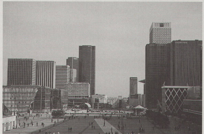
Neue Urbanität in «Big Buildings» ist eine Verbesserung gegenüber dem tristen Horror vacui innerstädtischer «Fuzos». Beispiel Media-Park in Köln.
