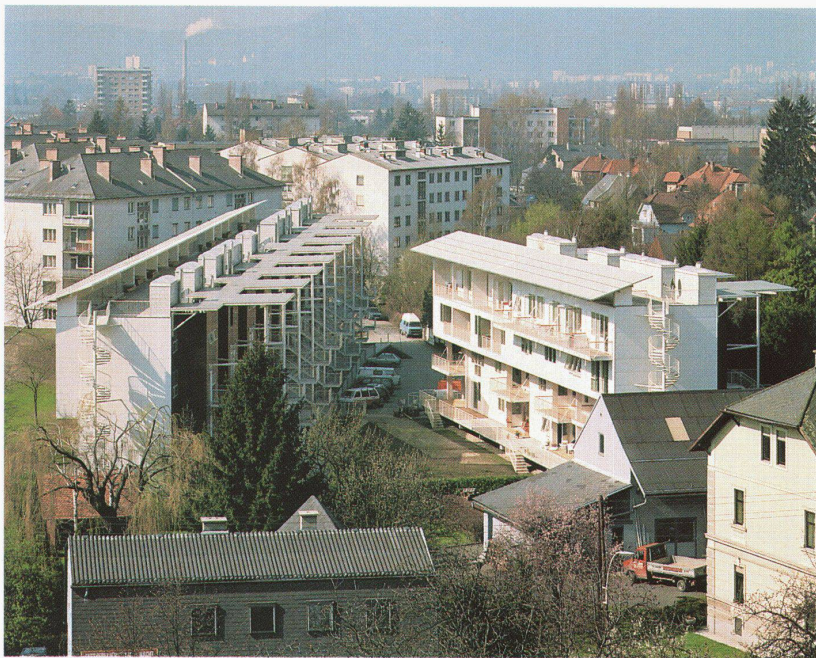
Gesamtanlage von Nordosten L'ensemble vu du nord-est Total complex from the northeast
