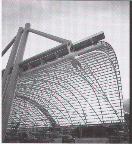
Projekt: Postautostation Chur Hallendach - Architekten: Brossi Chur & Obrist St.Moritz
